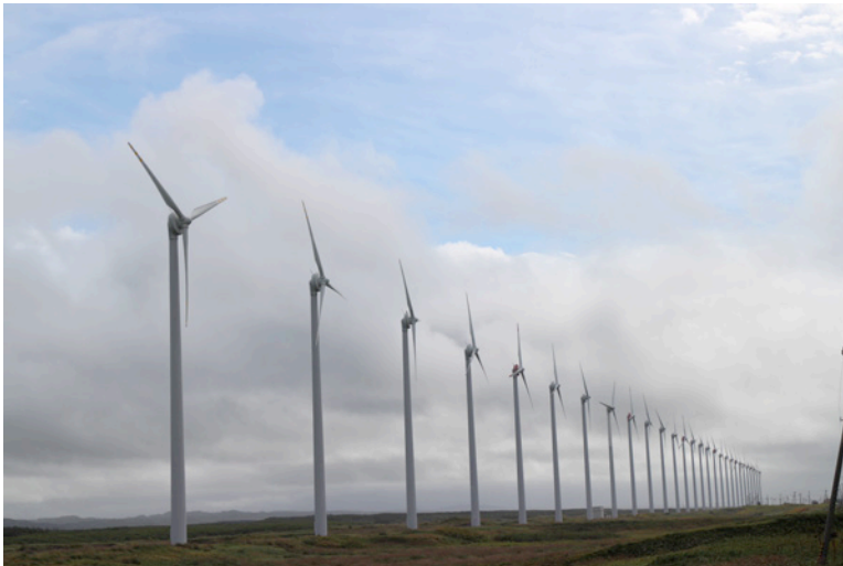
北海道幌延町にあるオトノルイ風力発電所 (750kW,28基が海岸線と平行に一列で建てられている)
